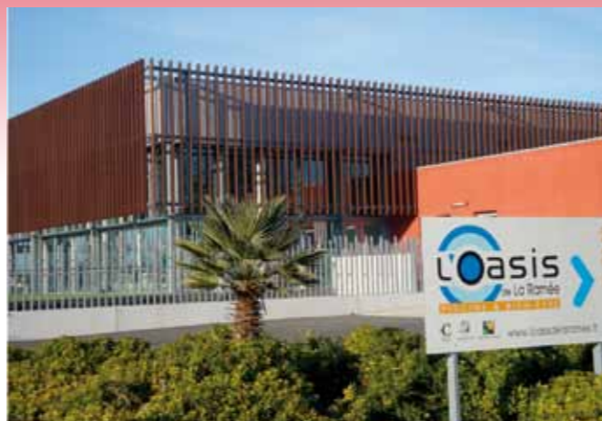
Piscine Intercommunale l'Oasis à la Ramée Réalisée avec l'aide du Conseil Général
